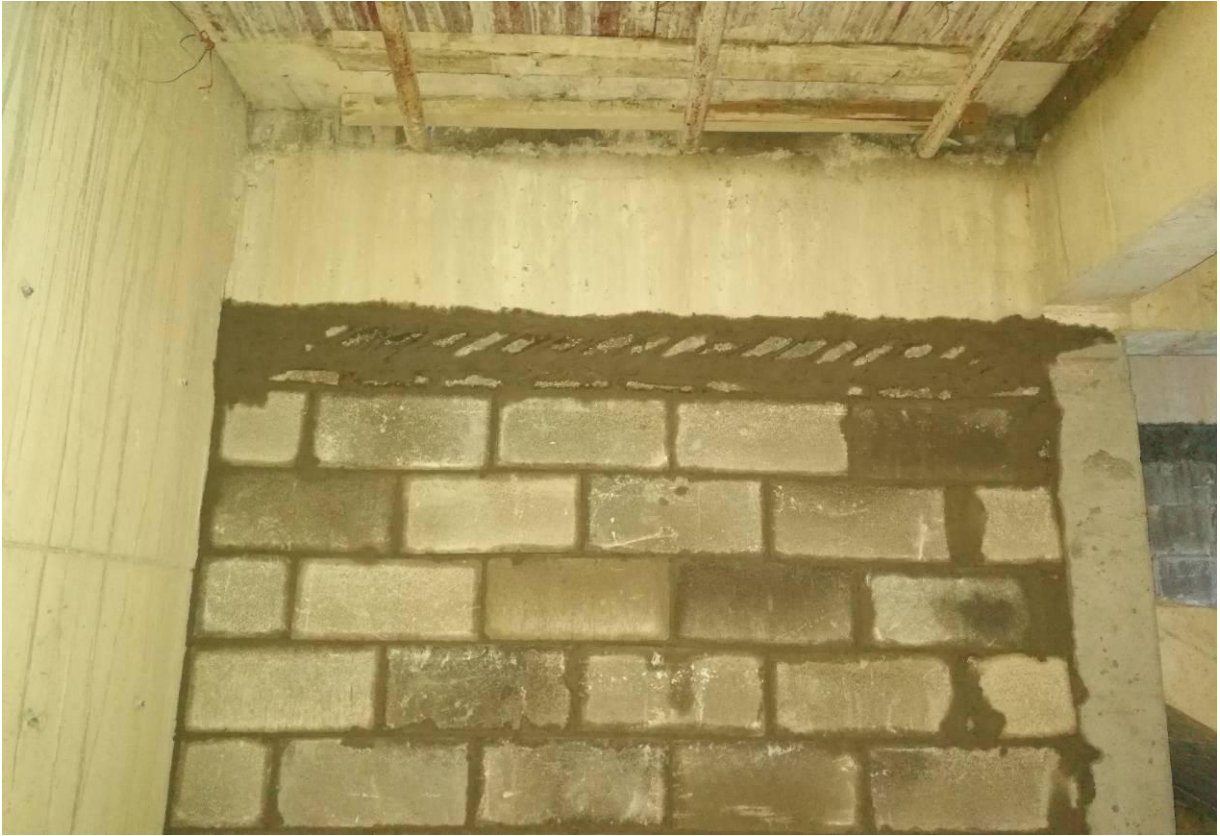
②. 外墙封顶砖外侧砌体灰缝砂浆仍不饱满。
