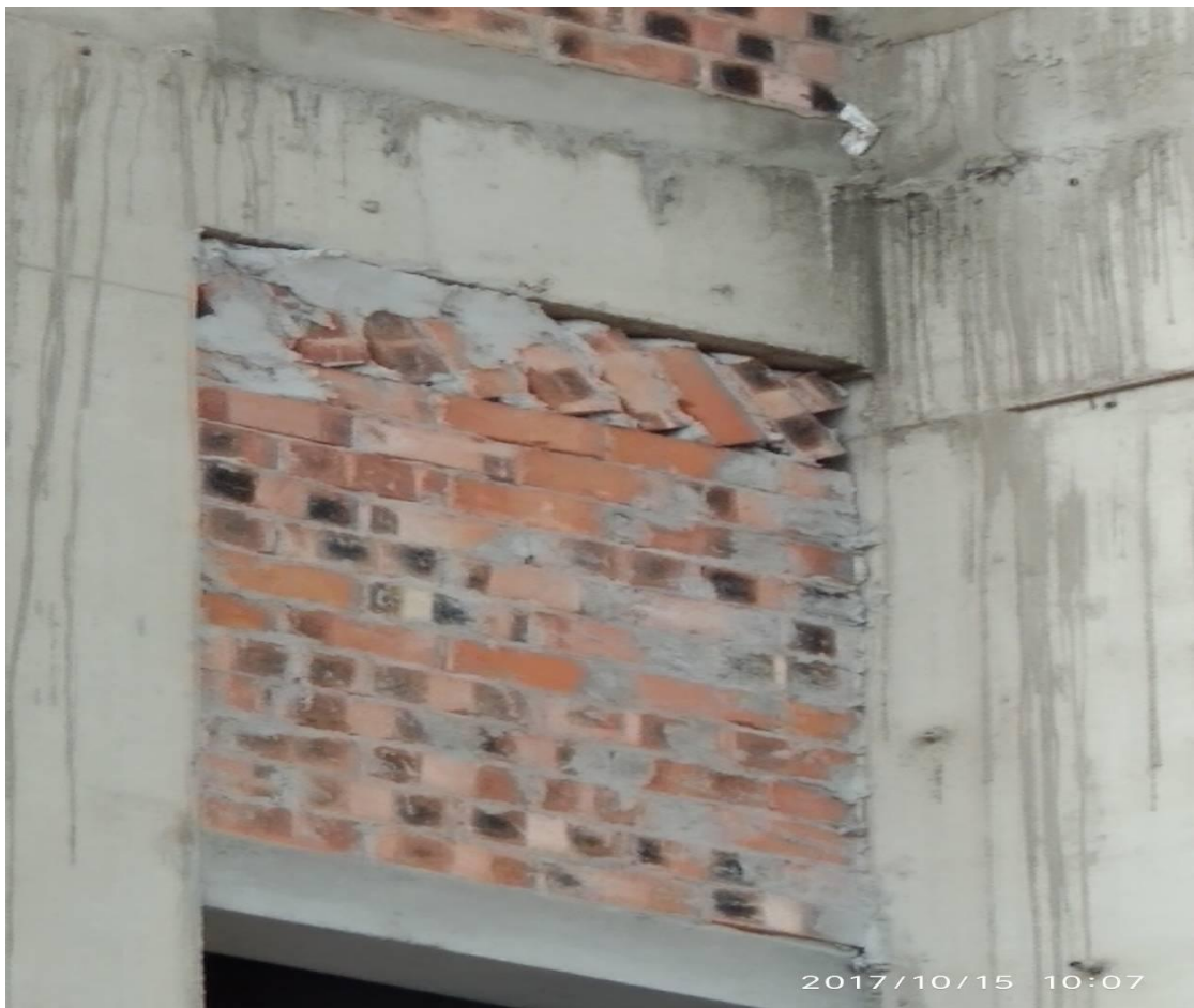
②. 外墙封顶砖外侧砌体灰缝砂浆仍不饱满。
