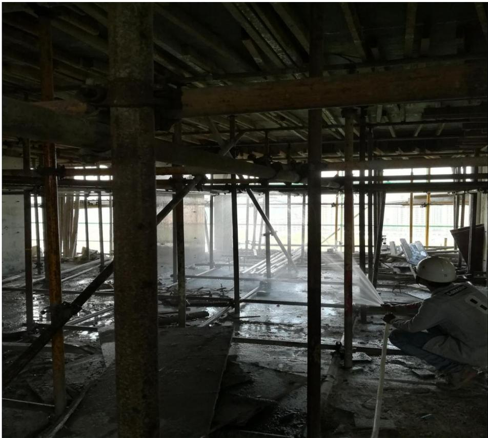
2. 伸缩缝处混凝土存在蜂窝麻面，项目部检查发现后，上部的楼层及时加强管控，安排工人加强加固，现都消除。
