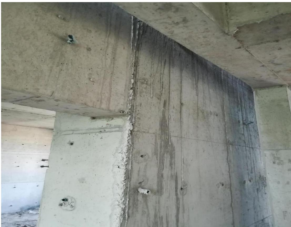
3. 项目部现场检查发现后，已发通知给施工单位要求劳务，严格按通知的相关内容执行，模板过旧、过烂的更换新模板，现已改进，缺楞、掉角的现象已基本消除。
