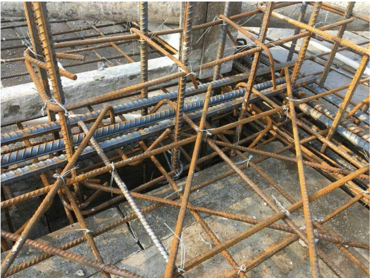
③. 个别梁钢筋的面筋与二排钢筋排距过大；已马上安排施工人员进行调整。
