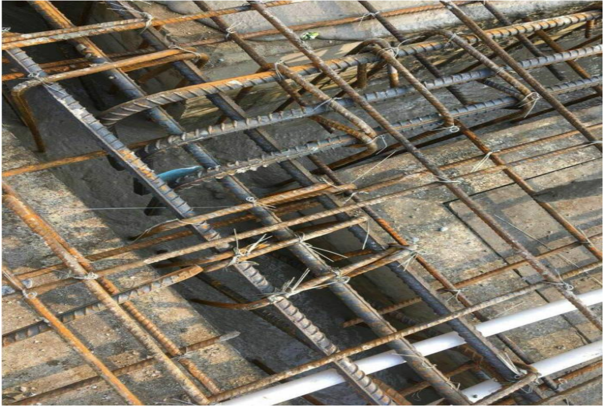
③. 个别梁钢筋的面筋与二排钢筋排距过大；已马上安排施工人员进行调整。
