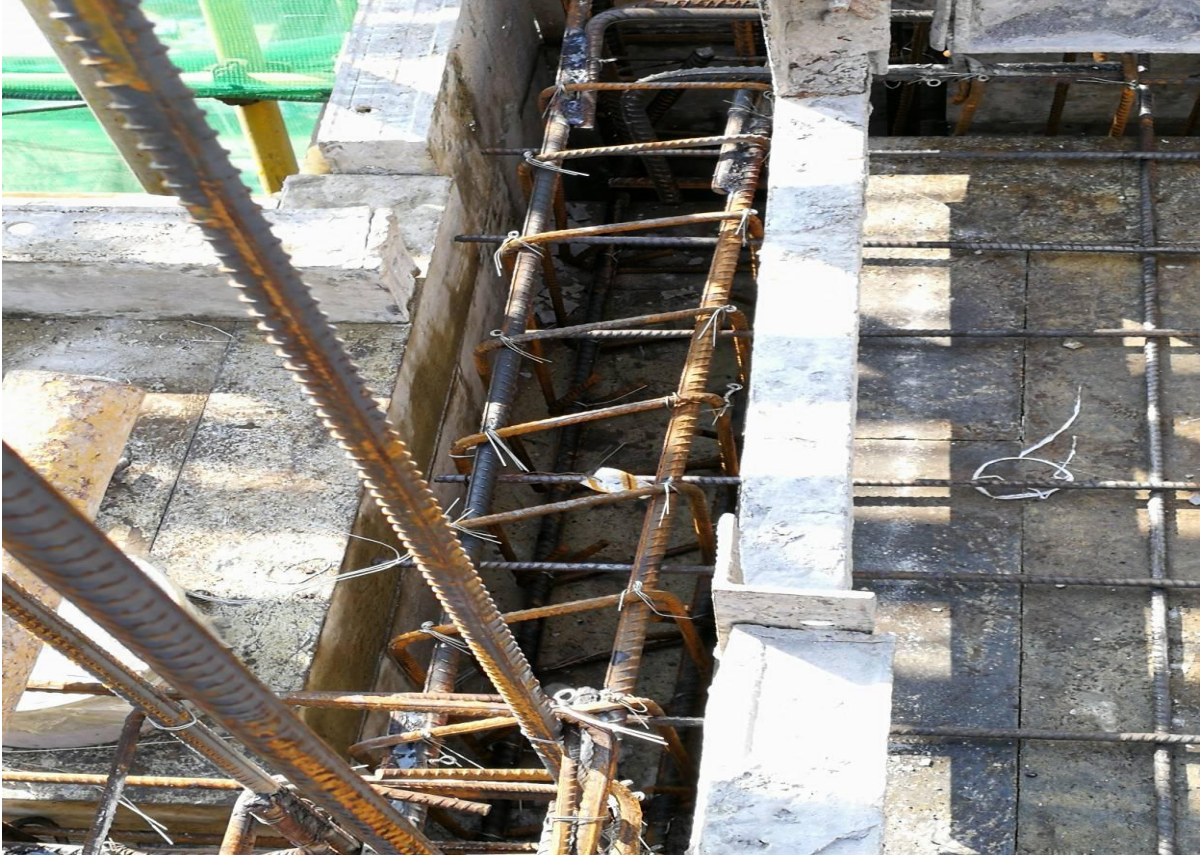
②. 主次梁交接部位加密箍筋间距过大。
