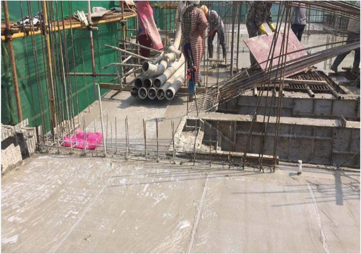
3. 砼工程：因楼层预埋管线比较多，而且大小管线相互上下交叉，我施工单位严格按照规范要求振捣密实，并控制楼板和保护层厚度。
