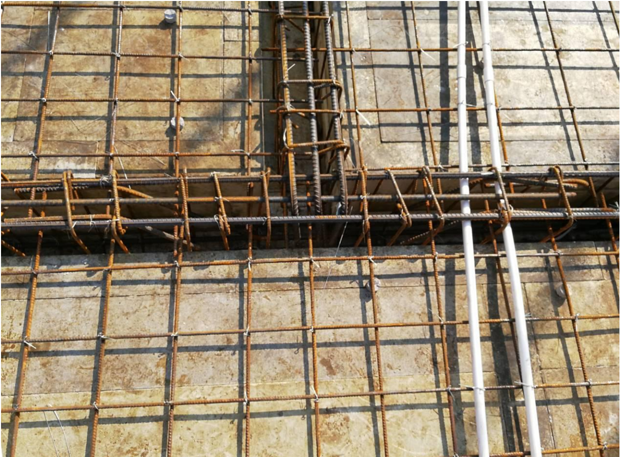
②. 主次梁交接部位加密箍筋间距过大。
